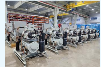
냉동기 조립반, B동
